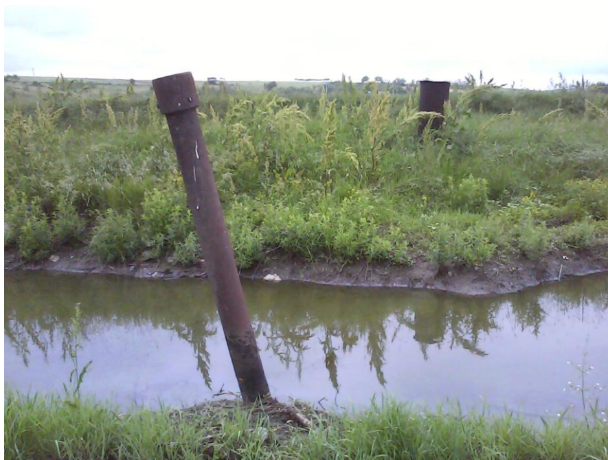
Poza 5 - traseu tronsonul II – traversare fosta albie parau Teslui in zona robinetului existent montat in tub metalic de protectie
